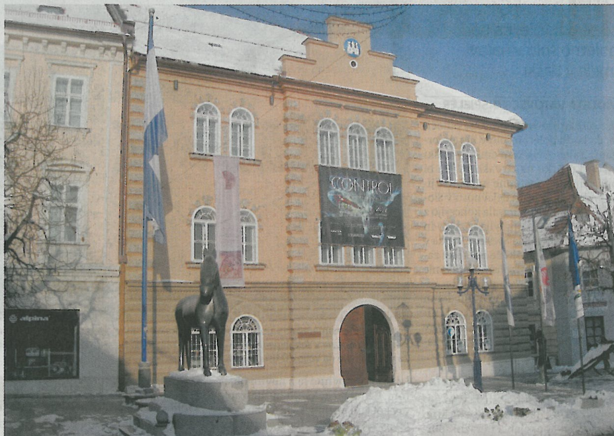
Delno obnovljena nekdanja mestna hiša, zdaj domicil muzeja in galerije na Glavnem trgu 24 v Slovenj Gradcu (Karin Potočnik)
